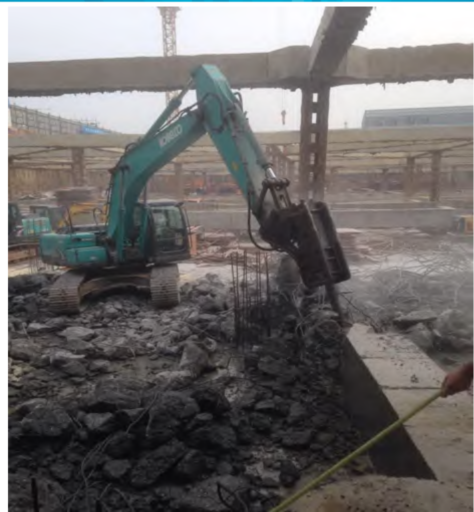
基坑第二道支撑采用机器破除
