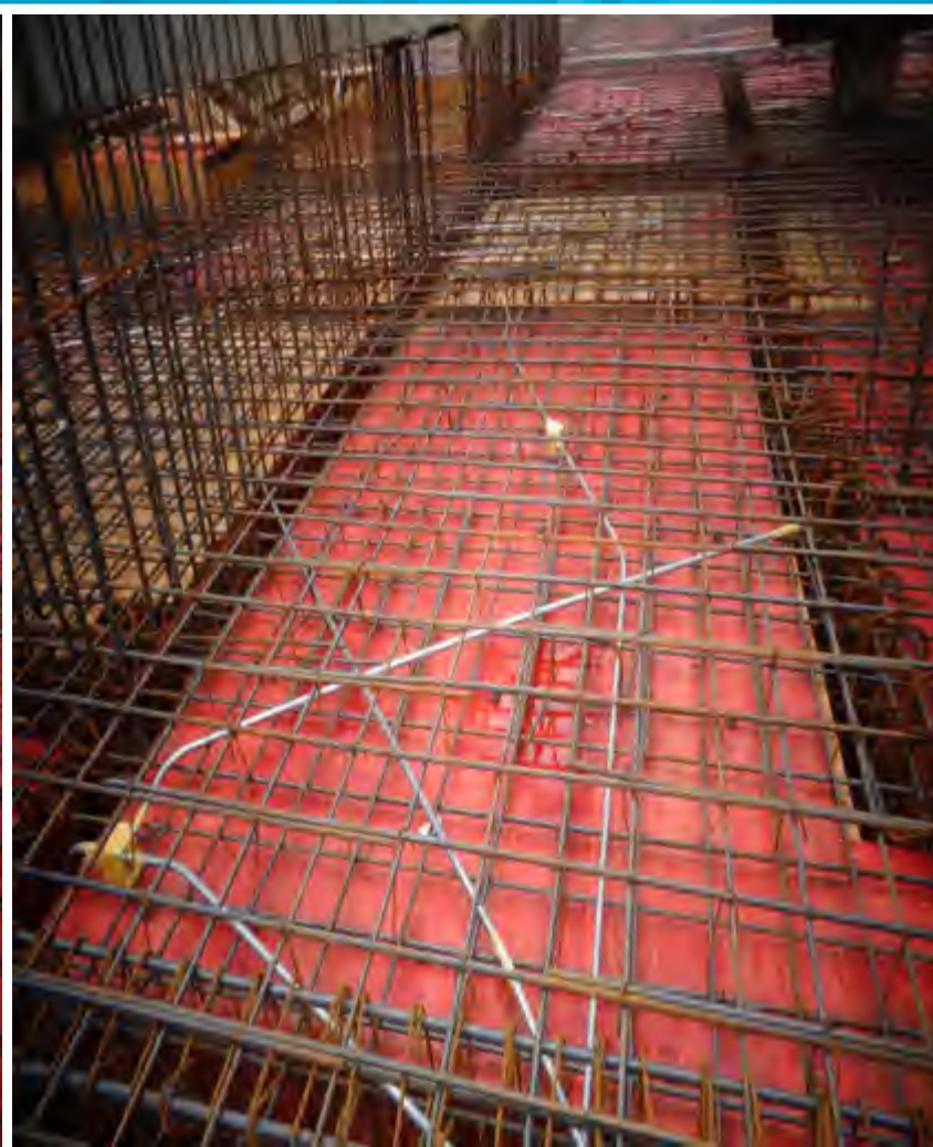
地下室负二层结平梁模板钢筋绑扎
