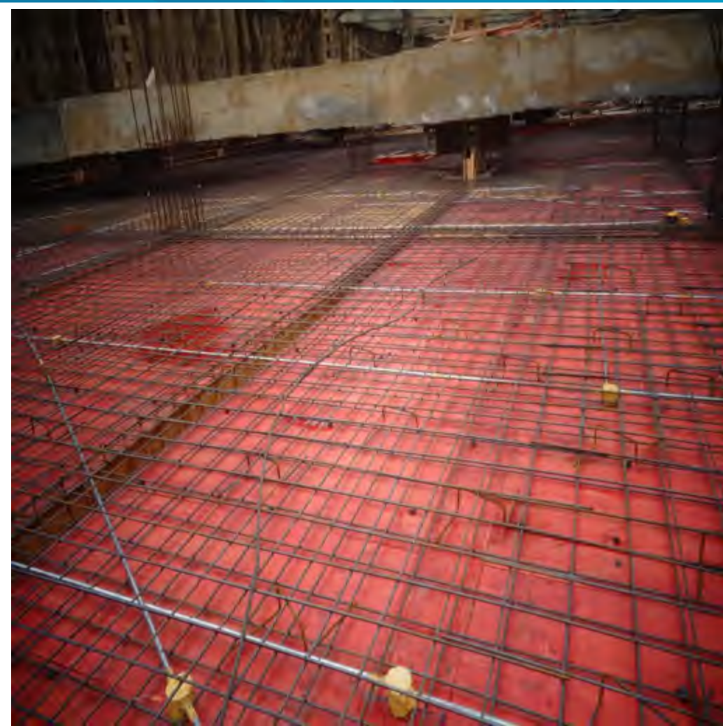
地下室负二层结平梁模板钢筋绑扎
