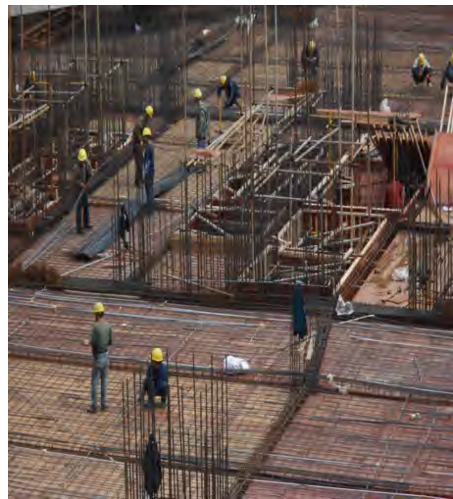
7区核心筒负二层结平梁板筋绑扎
