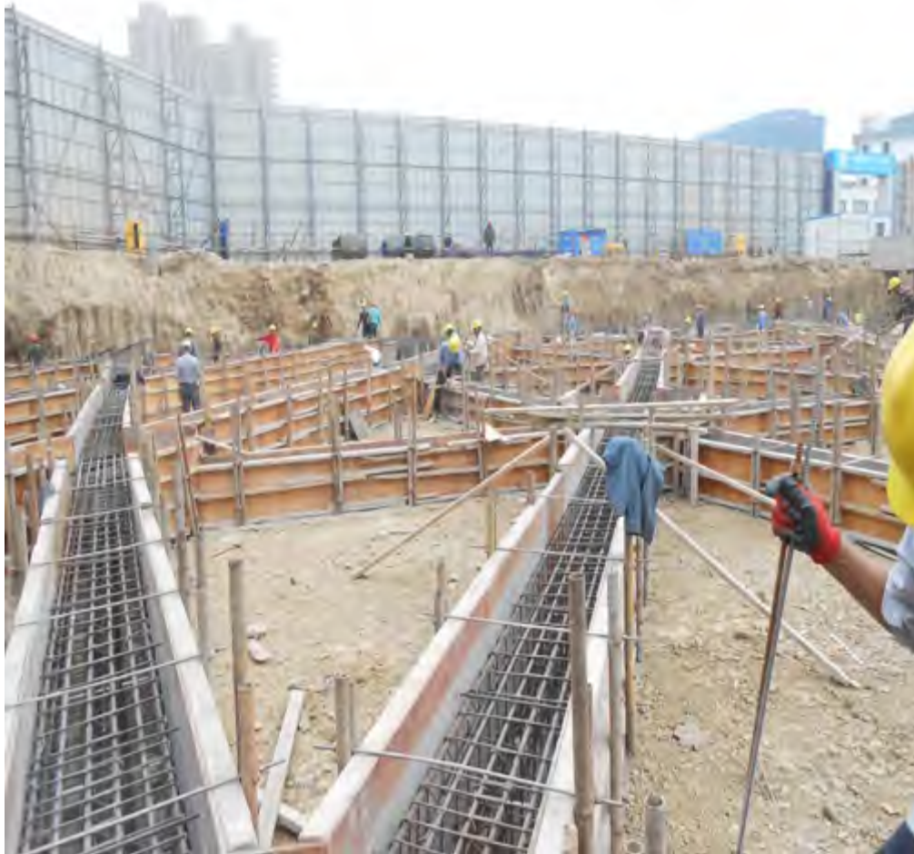
第一道支撑钢筋、模板施工
