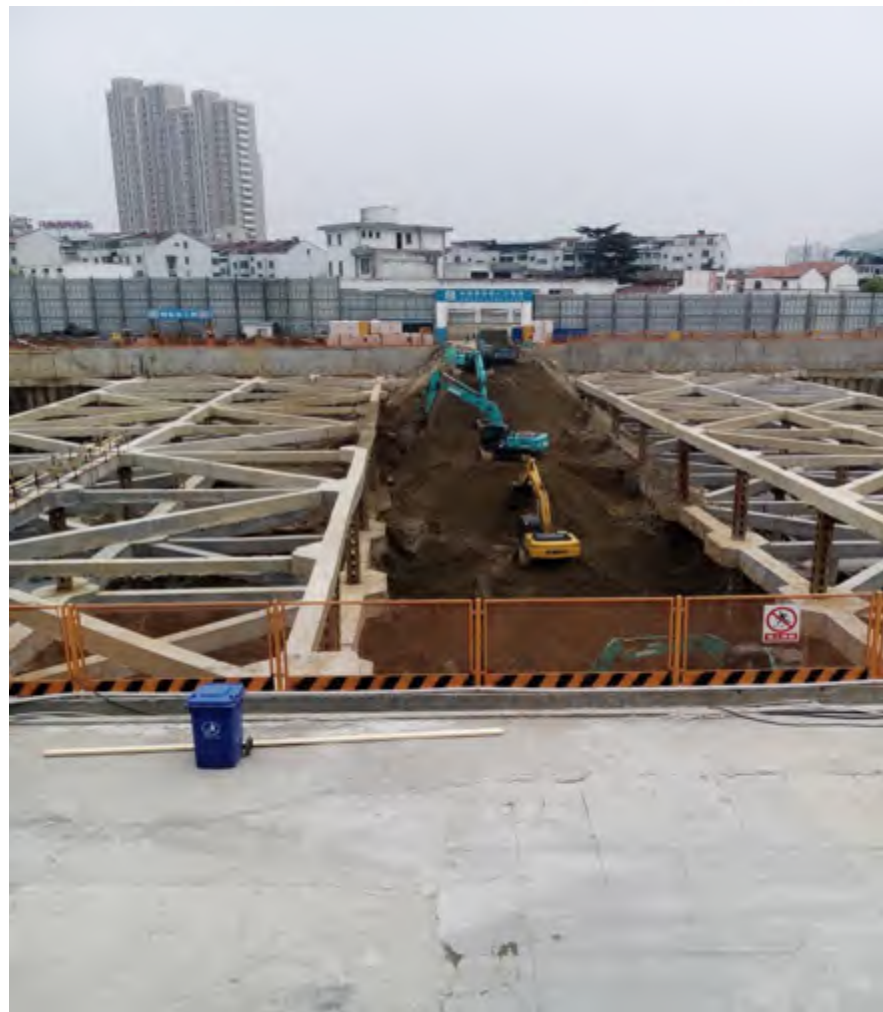
基坑二层土方开挖
