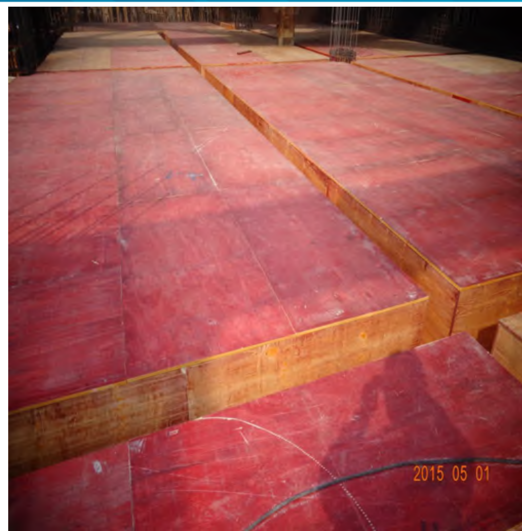
地下室负二层结平梁模板施工
