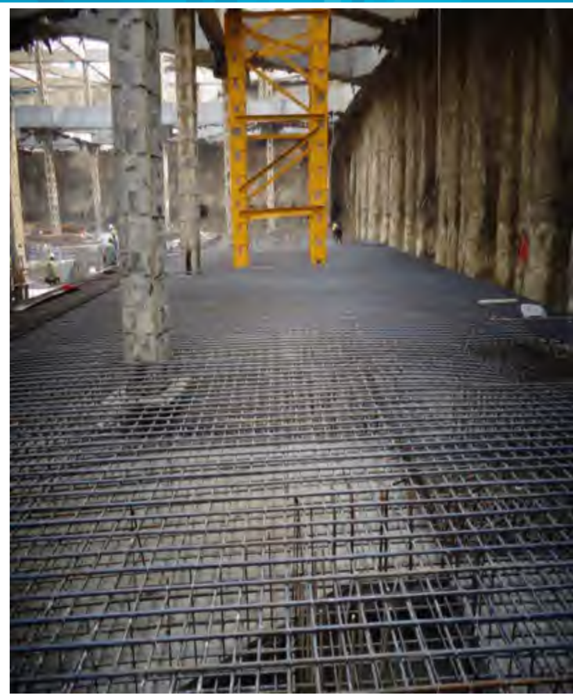
基础底板、承台钢筋绑扎
