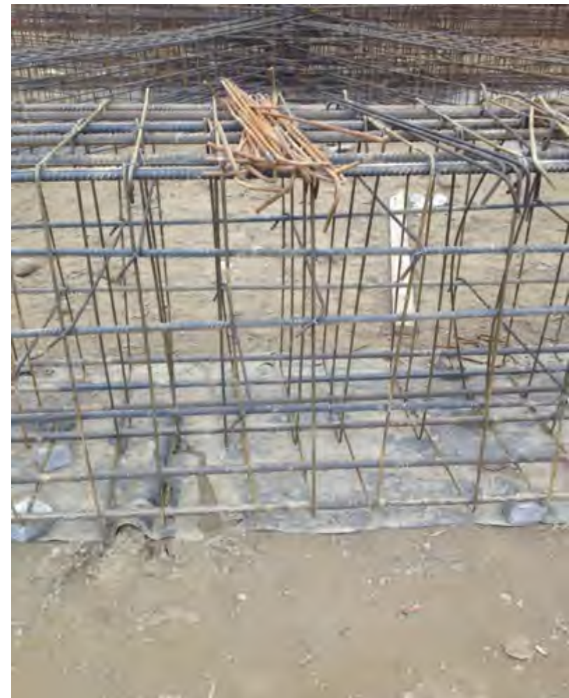
基坑第二道支撑钢筋绑扎
