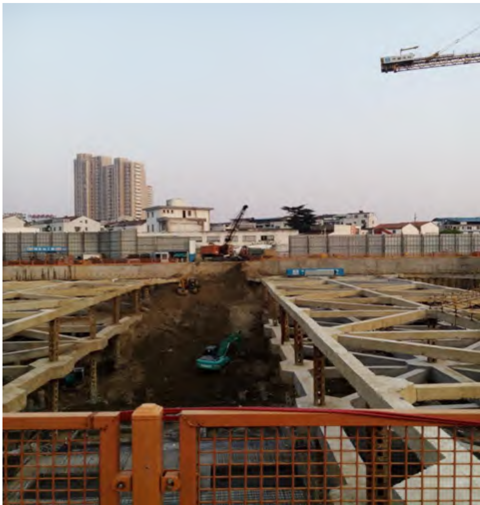
基坑二层土方开挖
