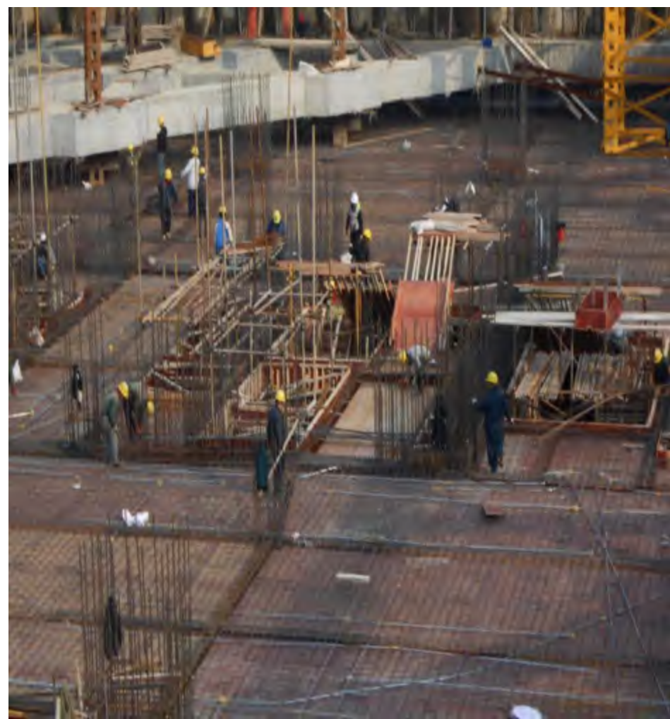
7区核心筒负二层结平梁板筋绑扎
