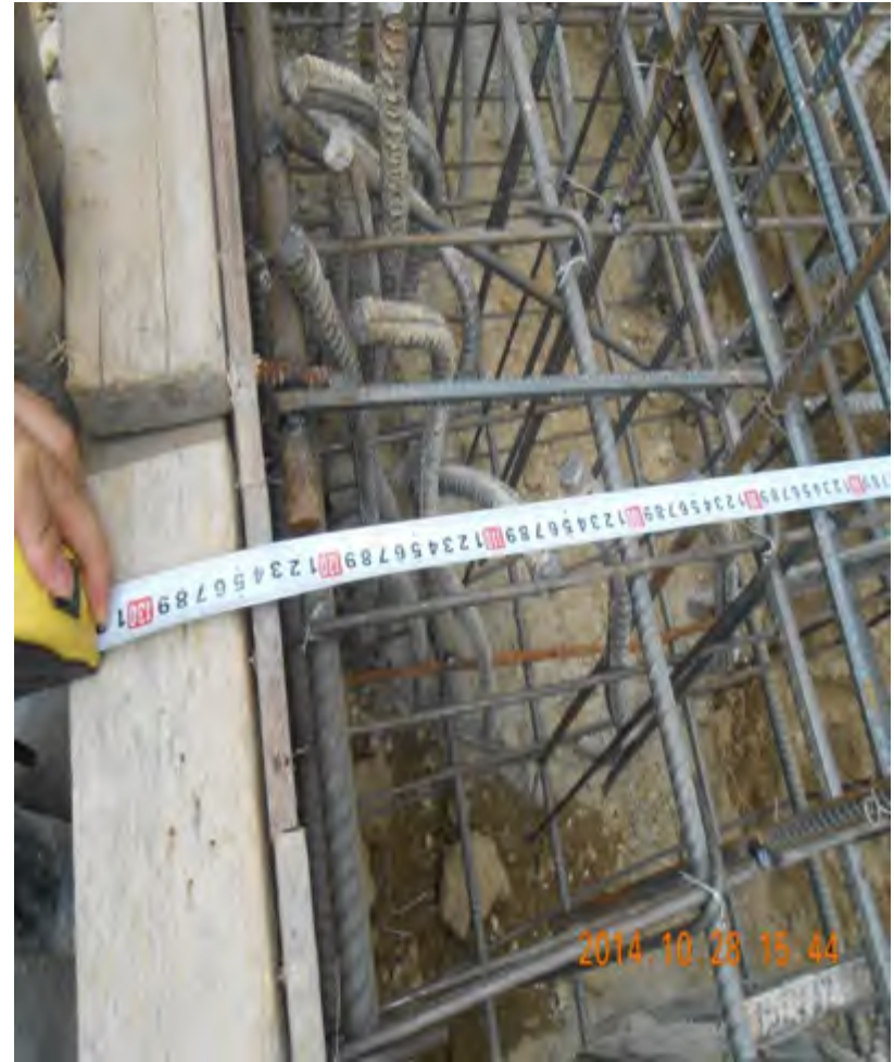
第一道支撑钢筋、模板施工
