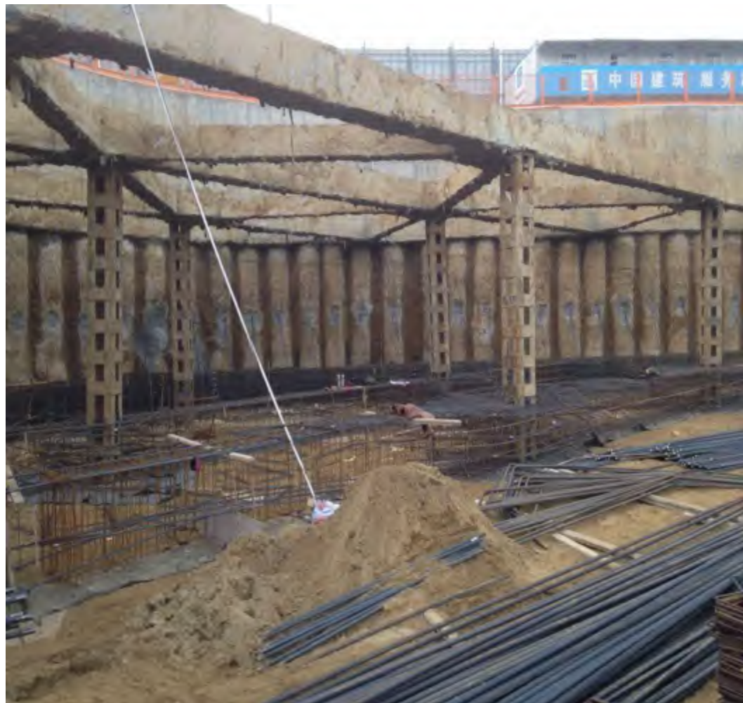
基坑第二道支撑钢筋绑扎
