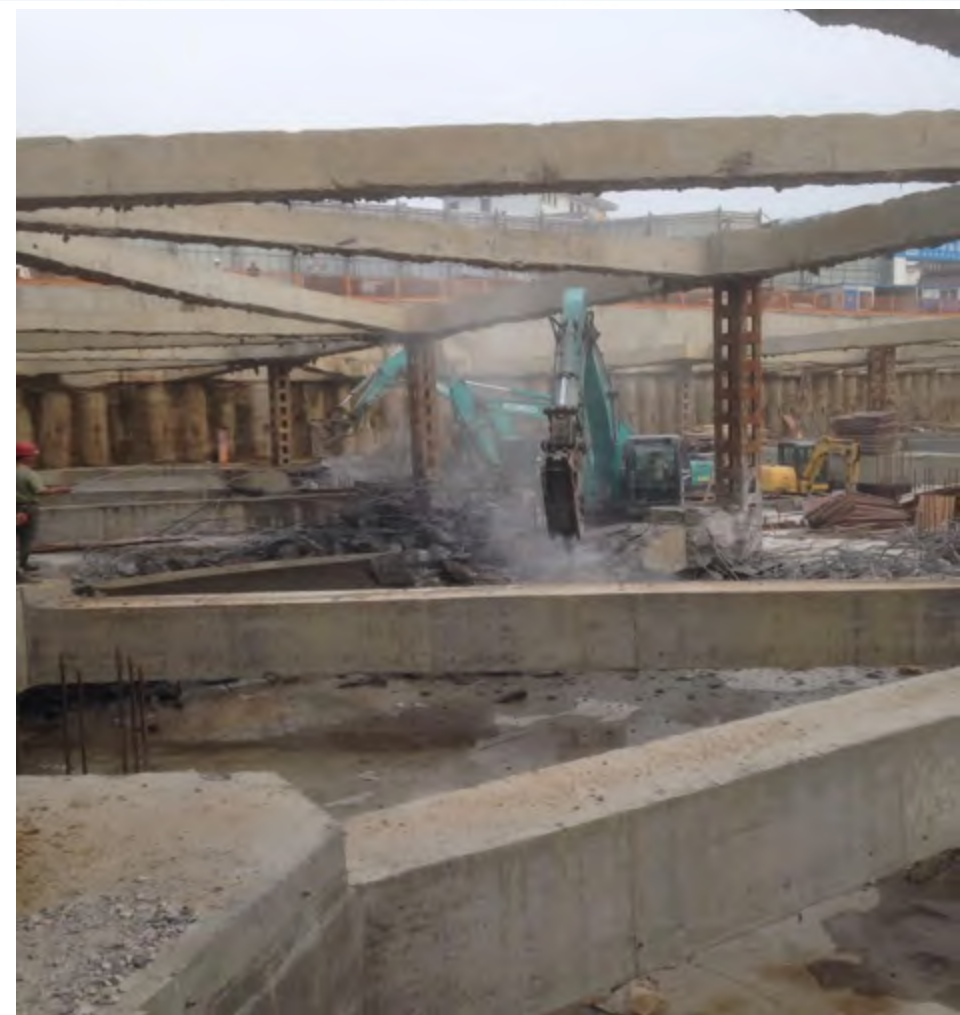
基坑第二道支撑围檩破除
