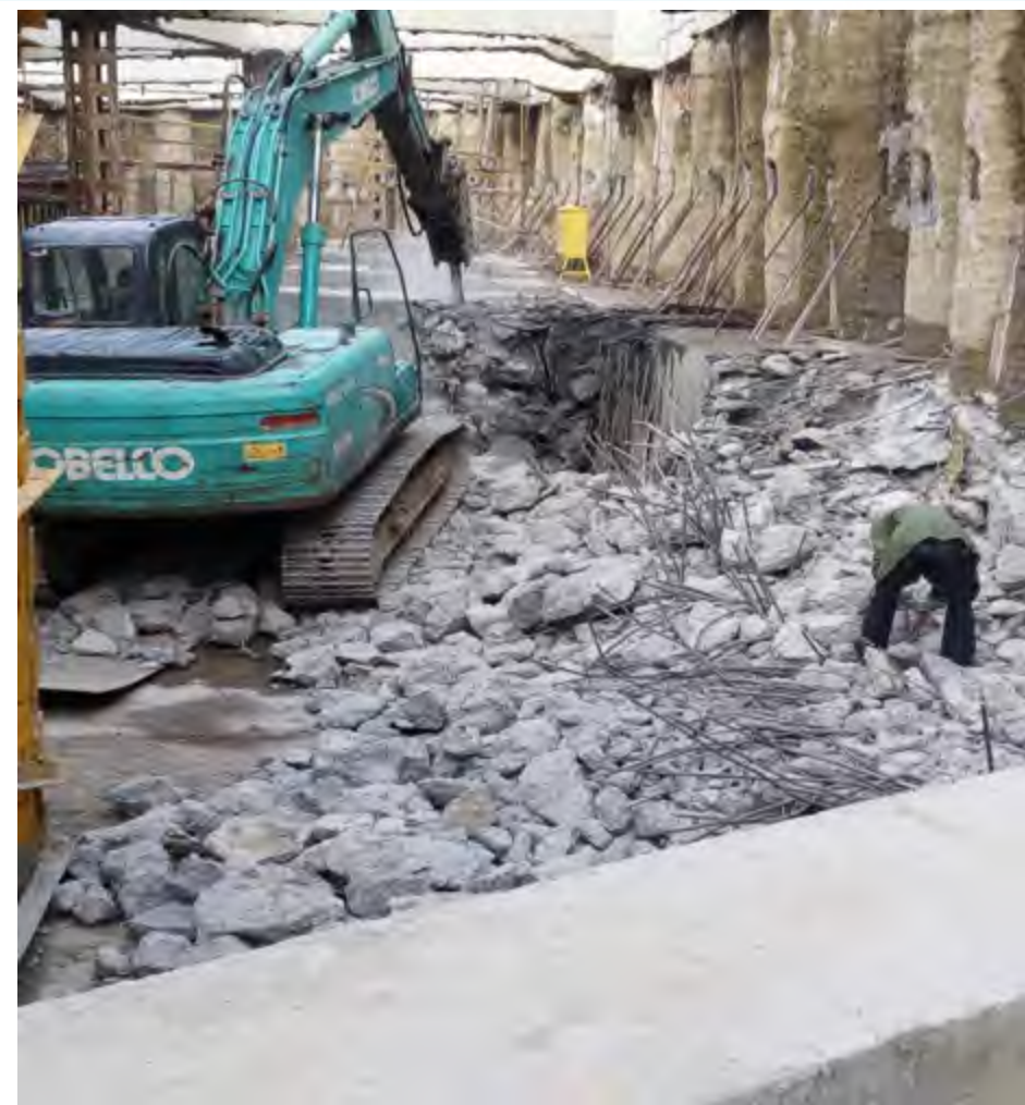
基坑第二道支撑围檩破除
