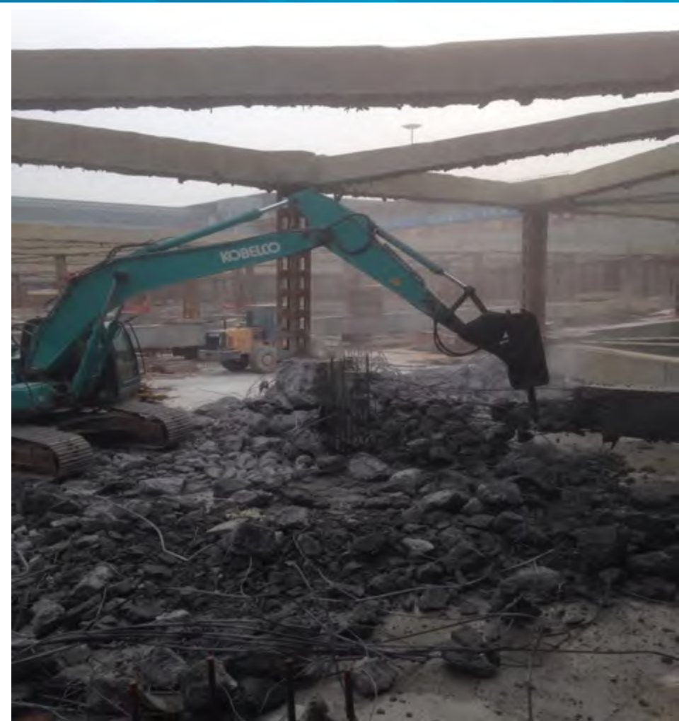
基坑第二道支撑采用机器破除
