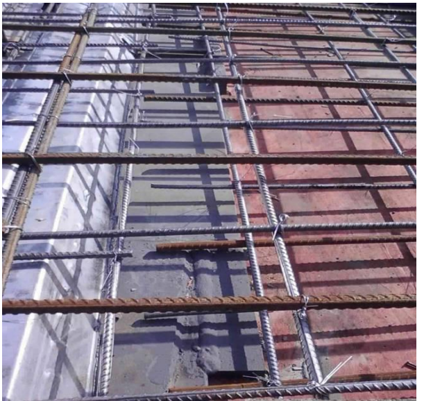
热镀锌钢楼承板顶面悬挑部位(二)
