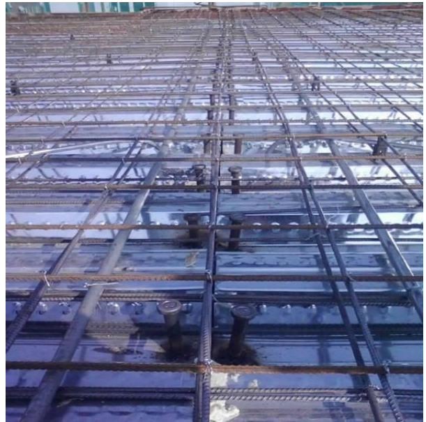
热镀锌钢楼承板顶面钢梁部位(二)
