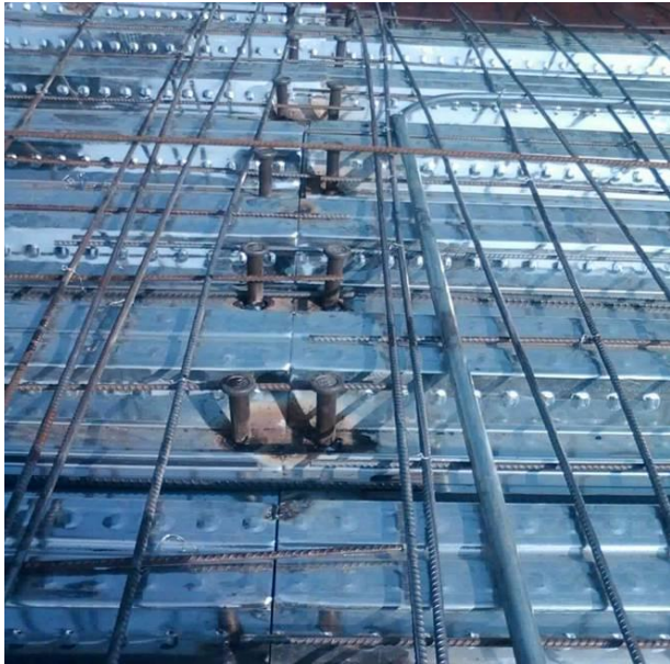
热镀锌钢楼承板顶面钢梁部位(一)
