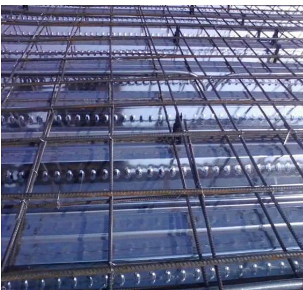
热镀锌钢楼承板顶面(二)
