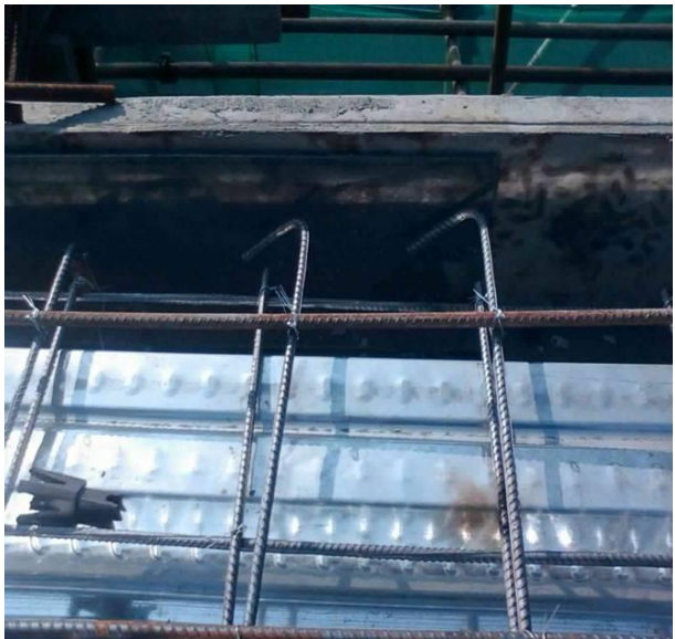
热镀锌钢楼承板顶面边沿部位(一)
