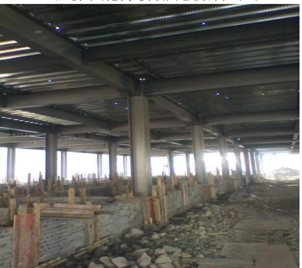
吊装后二层热镀锌钢承板铺装
