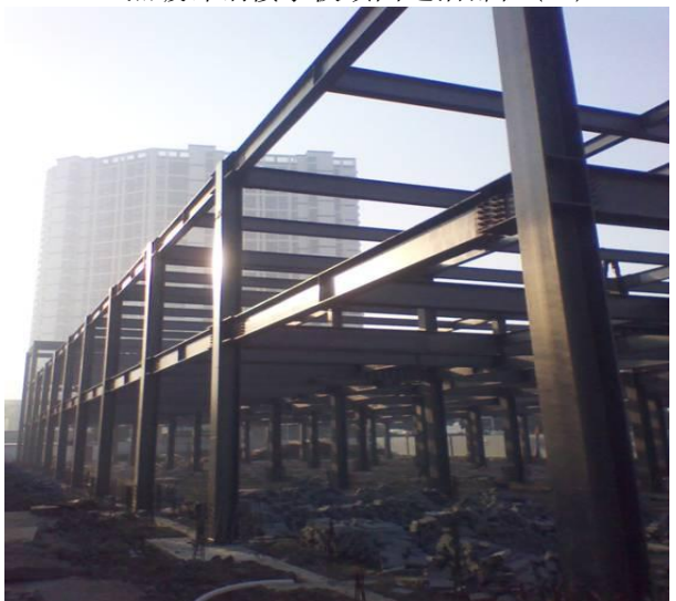
钢结构钢柱钢梁吊装后(共二层)
